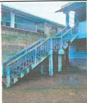
Foto 3: Mantenimiento realizado a barandales.
