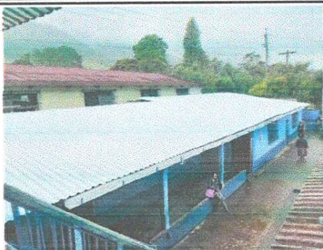
Foto 1: Sustrucción realizada con lamina troquelada.
