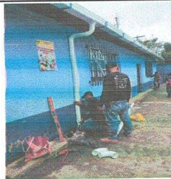
Foto 4: Trabajos realizados de mantenimiento, sustrucción de canales y bajada de agua.
